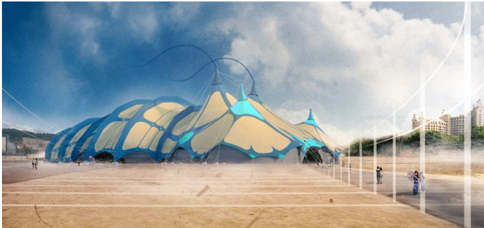
Exemple d'un projet de chapiteau pour la Chine que nous avons réalisé en phase APS. Surface au sol de 8500 m 2 . Arc de portée 75m et mât de 40m de hauteur.
