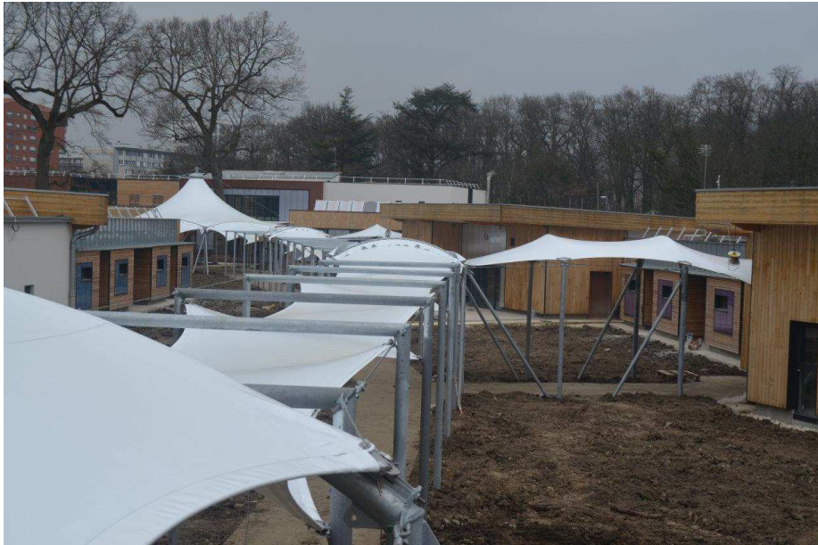
Auvent sur toiture Balaruc-les-Bains
